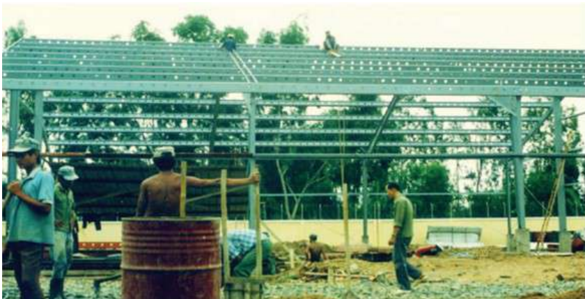
Khởi công xây dựng nhà máy
