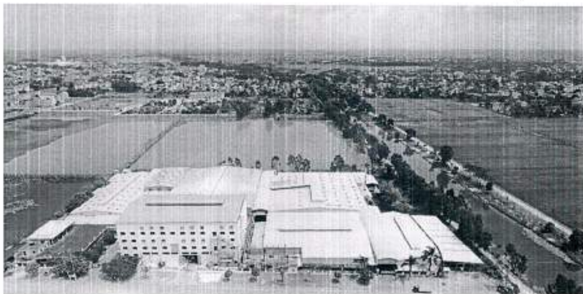
Nhà máy 1A, 1B
