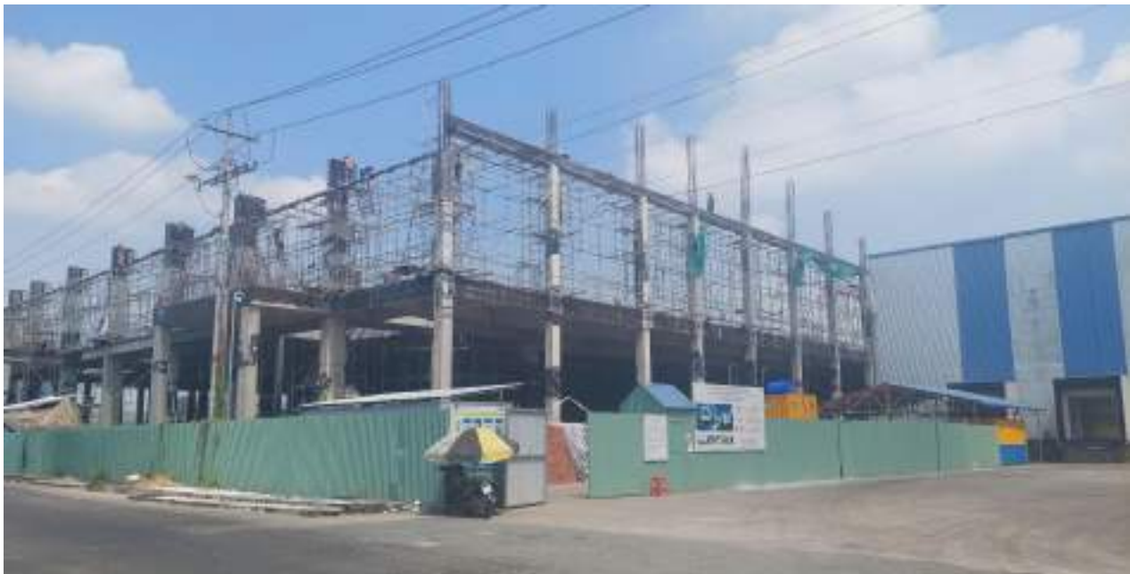
Nhà máy chế biến thủy sản Hoa Kỳ (Nhà máy số 03) đang xây dựng
