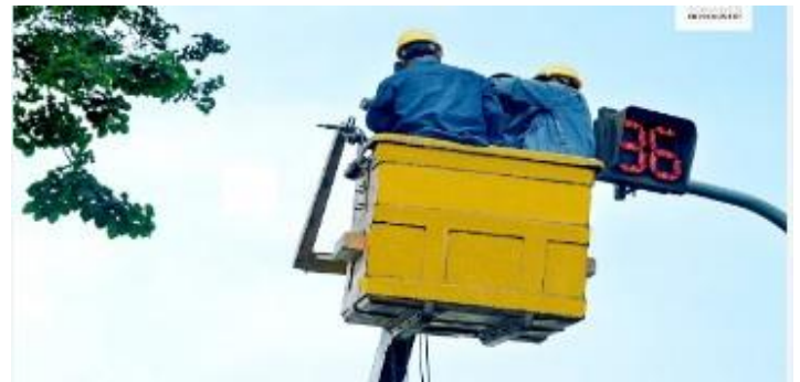
Thi công, duy tu sửa chữa hệ thống điện, chiếu sáng
