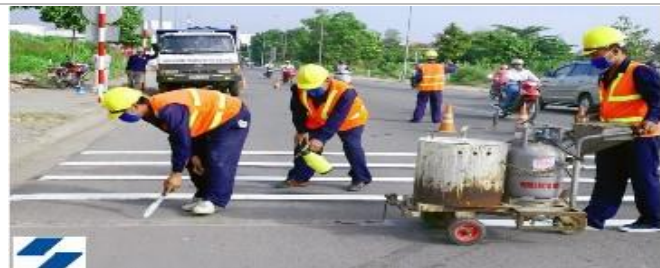
Duy tu đường, mương cống thoát nước
