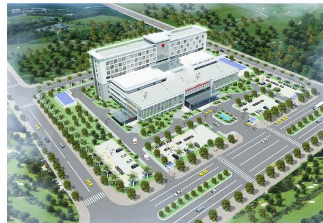
Thi công xây lắp
