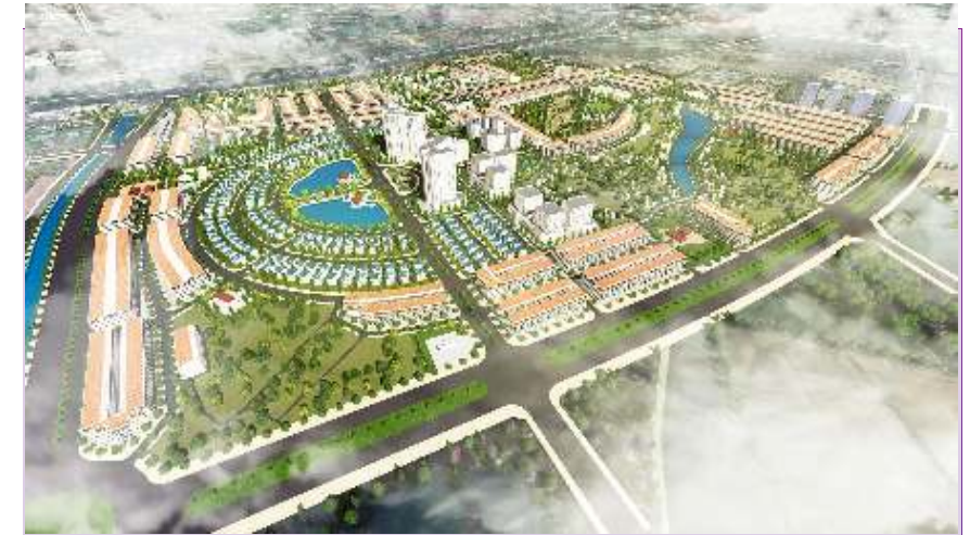
Dự án đầu tư Xây dựng khu nhà ở Tân Hà (Giai đoạn I)
