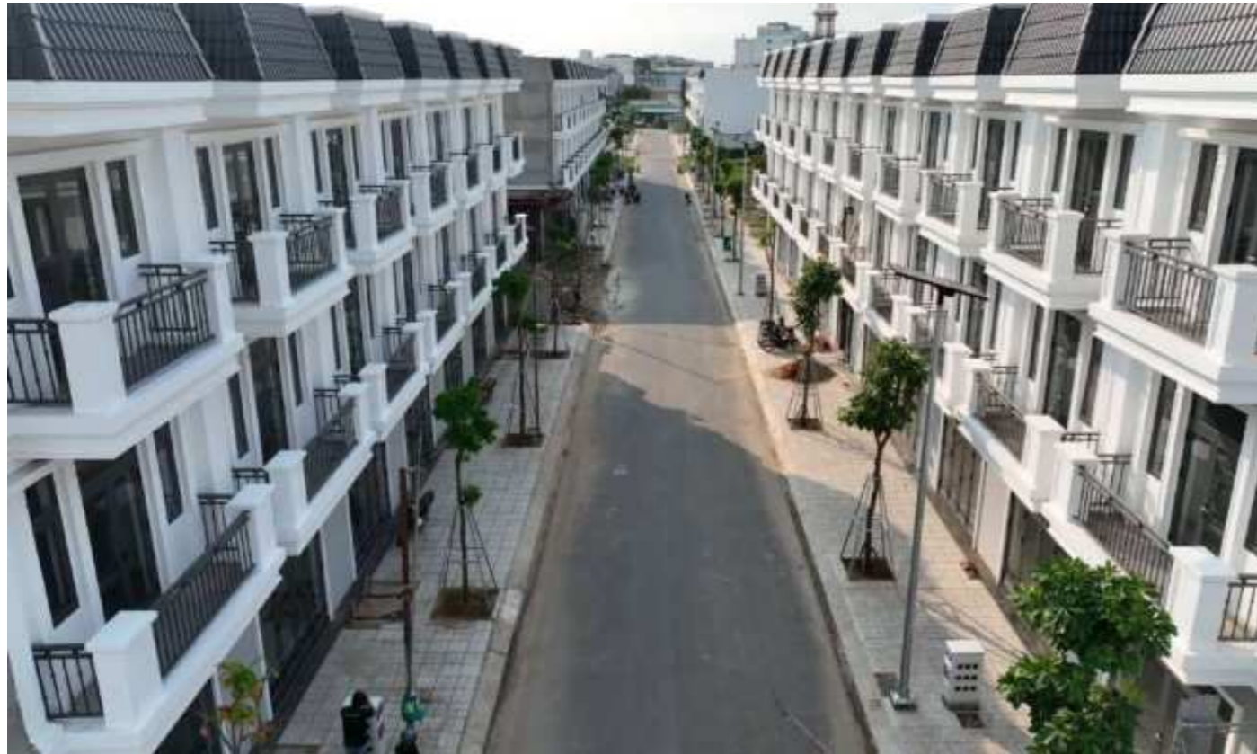
Dãy nhà thực tế dự án Everich Central
