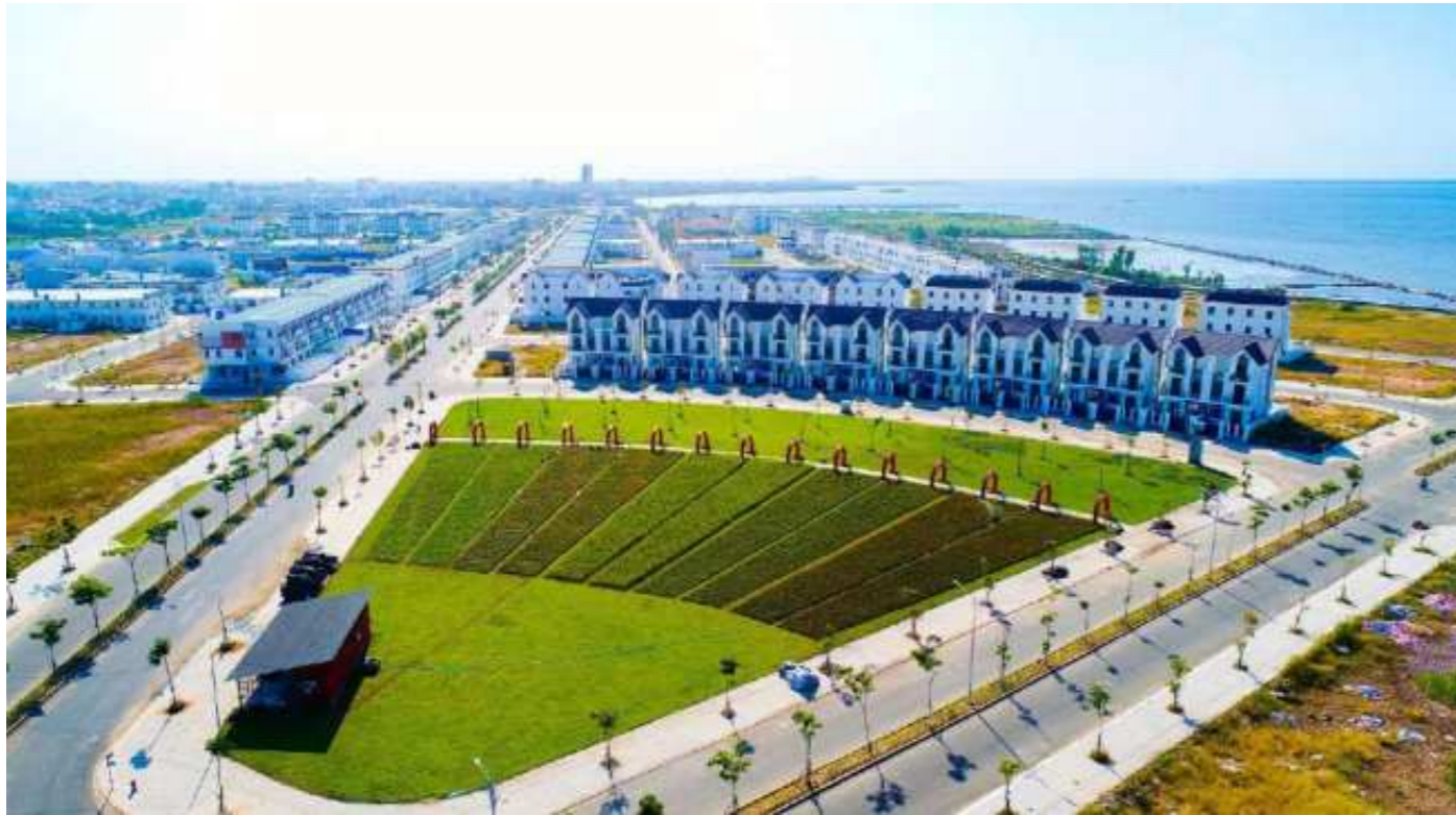
Vòng xoay Tú Xương – Điểm nhấn thiết kế tại dự án
