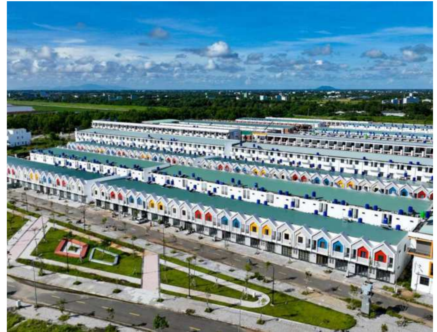
Một trong số các dãy nhà hoàn thiện đã bàn giao
