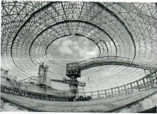
Hình ảnh 7: Giàn không gian CKDA xuất khẩu sang Namibia-Châu Phi
