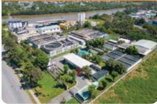
Nhà máy xử lý nước thải - Giai đoạn 3
