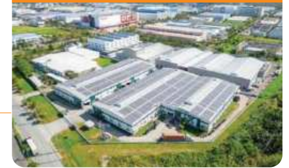
Dự án Hệ thống điện mặt trời áp mái Nhà xưởng Lô T4
