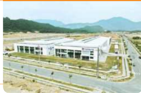
Nhà xưởng J4 - Giai đoạn 1 tại Khu CNC Đà Nẵng
