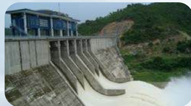
ĐẬP BÊ TÔNG TRỌNG LỰC ĐÀM LẤN (RCC) - HỒ CHỨA NƯỚC BÌNH ĐỊNH Cúp vàng công trình chất lượng cao Giải thưởng Bông lúa vàng Việt Nam lần thứ nhất, năm 2012
