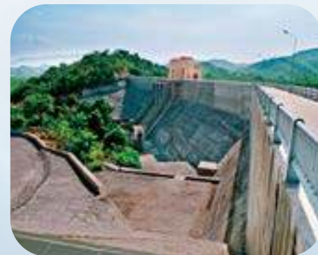
ĐẬP BÊ TÔNG TRỌNG LỰC CÔNG TRÌNH HỒ CHỨA NƯỚC LÒNG SÔNG TỈNH BÌNH THUẬN Công trình chất lượng tiêu biểu 5 năm (2000-2005)
