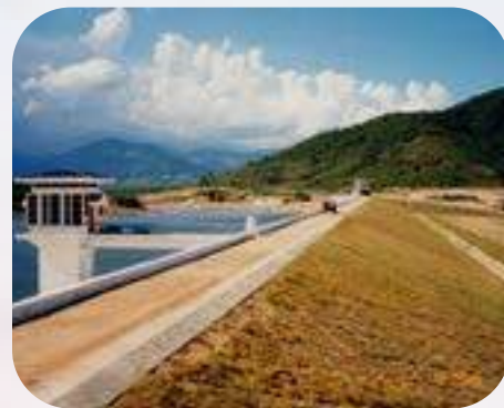
CỤM CÔNG TRÌNH ĐẦU MỐI THẠCH NHAM TỈNH QUẢNG NGÃI Công trình chất lượng tiêu biểu thập niên 90
