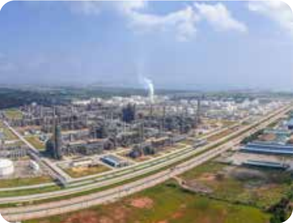
Nhà máy Lọc hóa dầu Nghi Sơn
