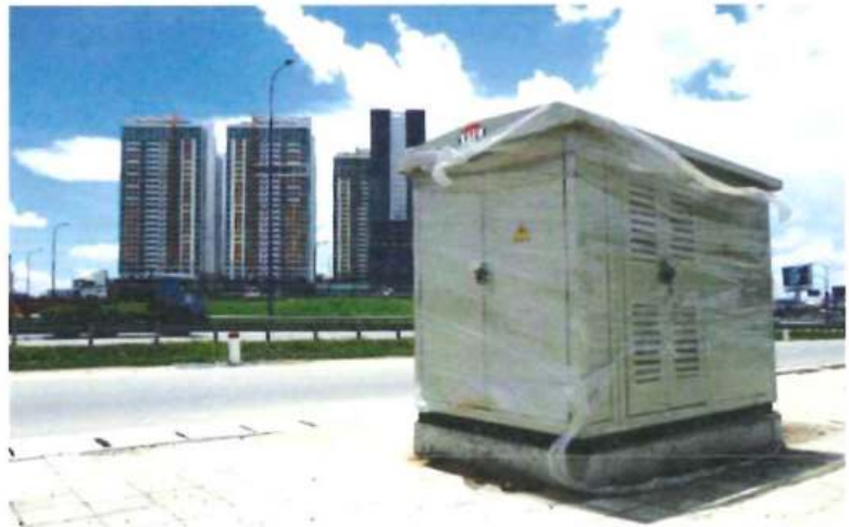
Các trạm biến áp trung thế cho dự án ngầm hóa lưới điện
