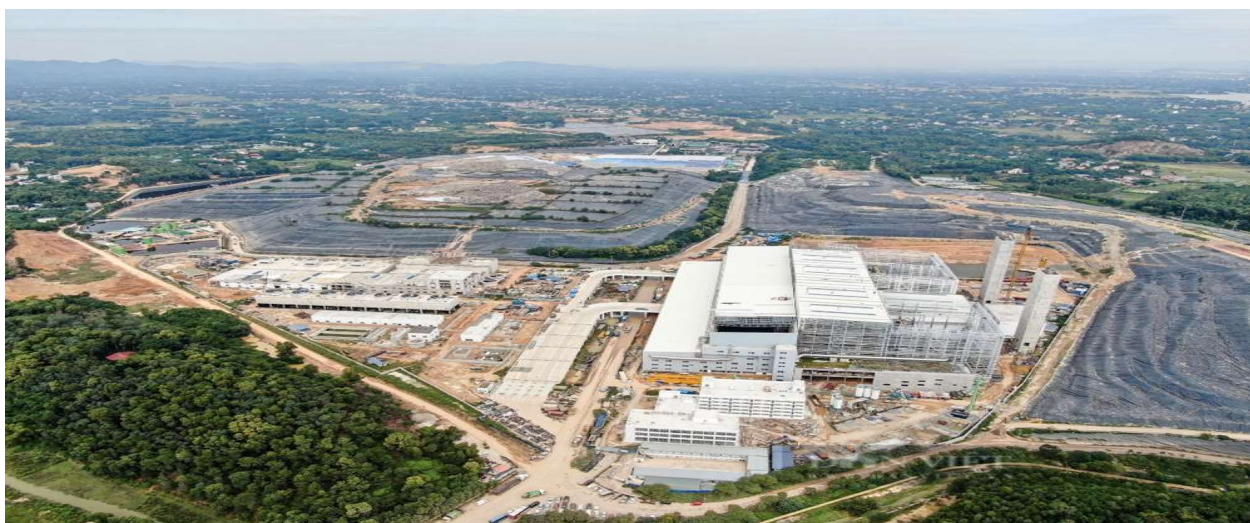
Nhà máy nhiệt điện rác Sóc Sơn
