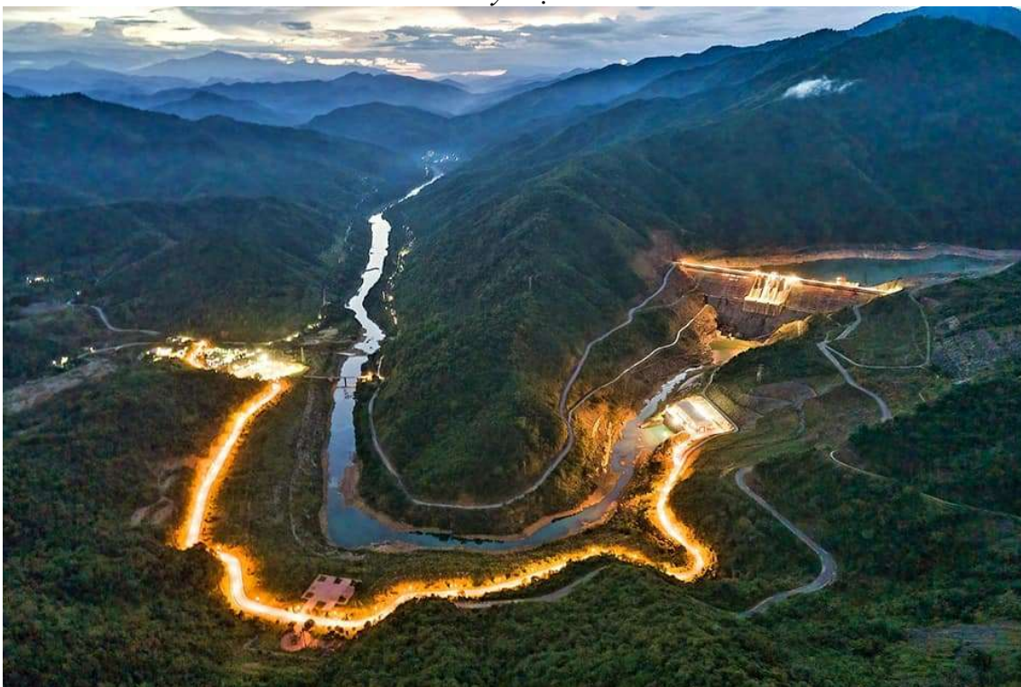
Thủy điện Bản Vẽ
