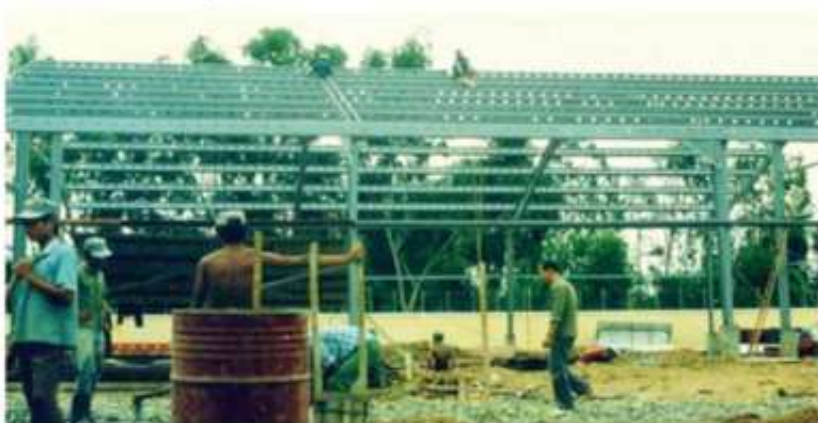
Khởi công xây dựng nhà máy
