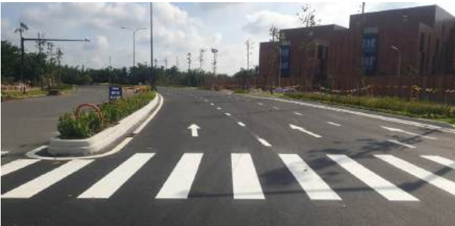
Đường D2 Waterpoint - Bến Lức, Long An
