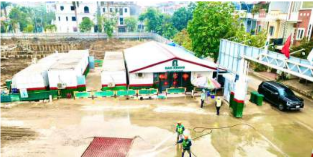
Công trình xây dựng An Đồng, Hải Phòng
