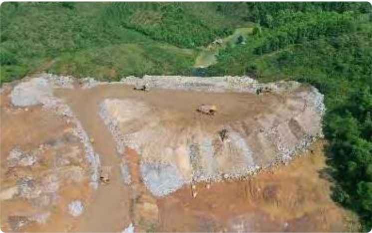
Đổ thải đất đá tại Bãi thải phía Bắc
