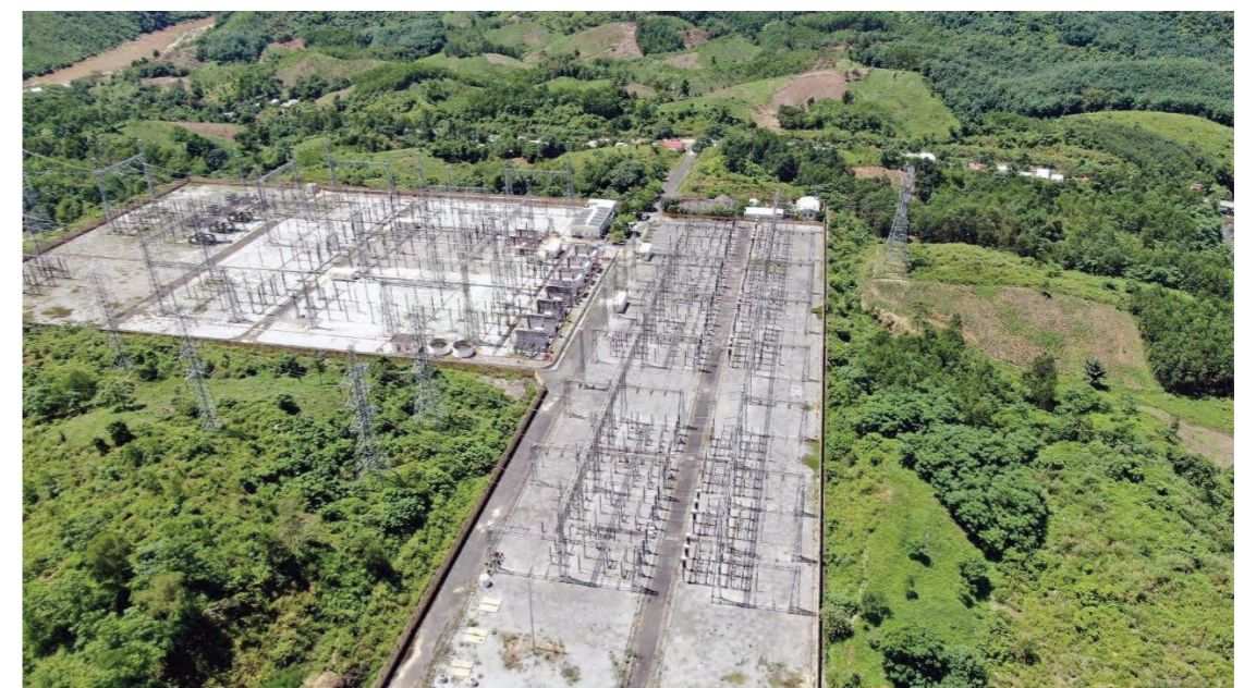
Tư vấn giám sát Đường dây 500kv Monsoon - Thạnh Mỹ
