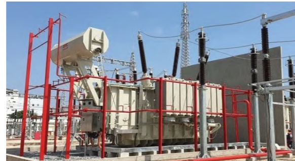
Dự án nâng công suất Trạm biến áp 500kV Quảng Ninh
