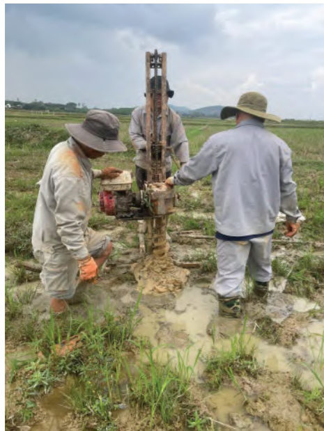
Công tác khảo sát địa chất tuyến đường dây 200kV đầu nối nhà máy điện gió Trường Sơn (Lào) về TBA Đô Lương (đoạn trên lãnh thổ Việt Nam)
