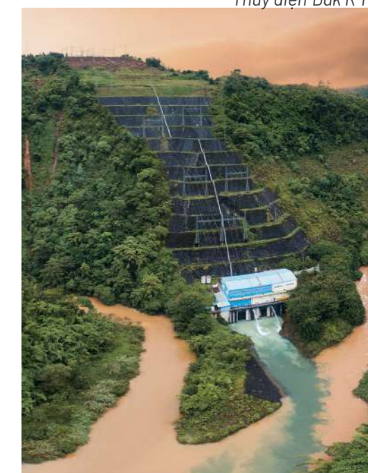
Thủy điện Đak R'Tih
