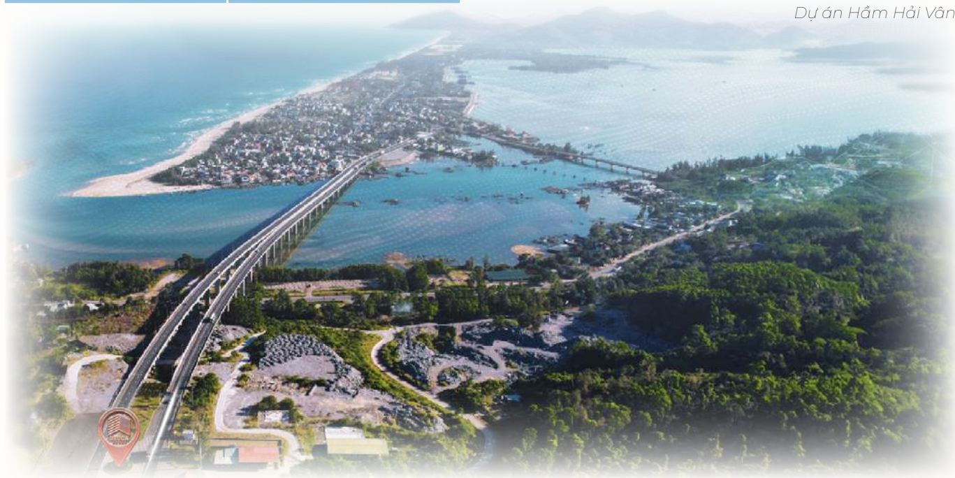
Dự án Hầm Hải Vân
