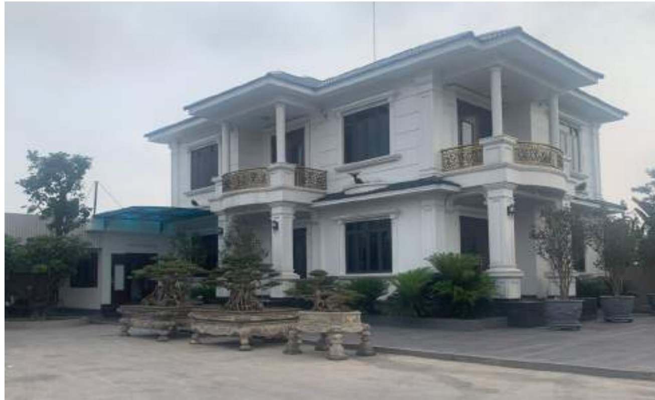
Thi công xây dựng cơ sở kinh doanh dịch vụ vận tải, vật liệu xây dựng và sửa chữa ô tô
