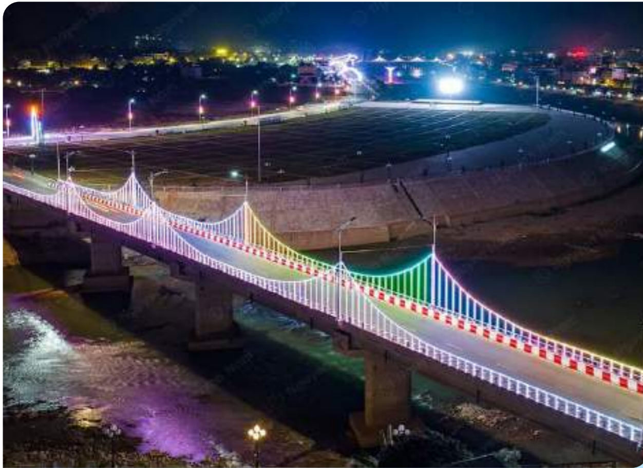
Gói thầu số 05: Thi công xây dựng công trình Cầu cứng qua sông Mã tại tổ dân phố 5, thị trấn sông Mã, huyện sông Mã, tỉnh Sơn La
