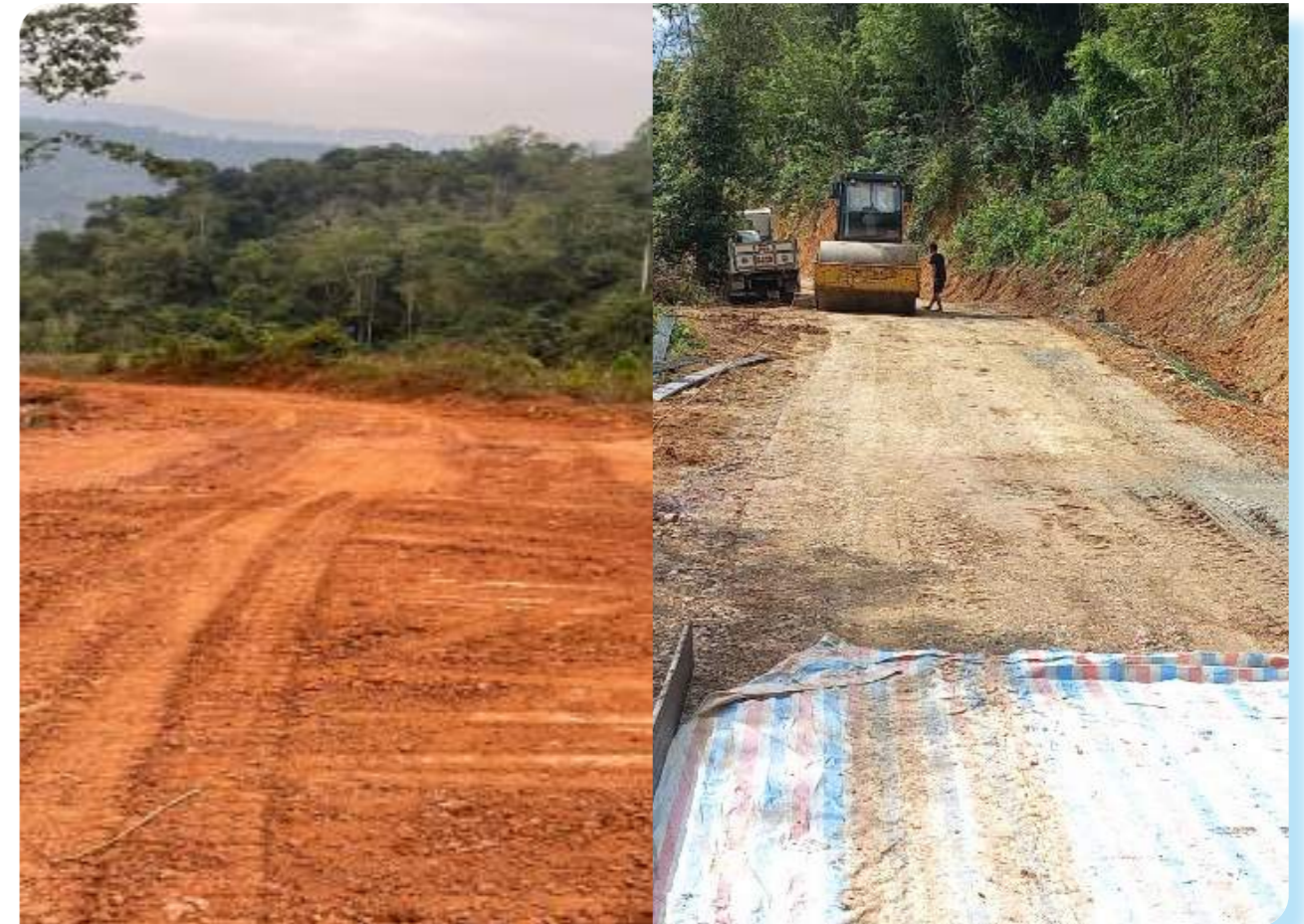
Gói thầu: Thi công xây lắp công trình (tuyến 2: Km0-:-Km3+600) thuộc công trình: Nâng cấp đường từ trung tâm xã Chiềng Tương - Đin Chí, Pom Khóc, xã Chiềng Tương, huyện Yên Châu
