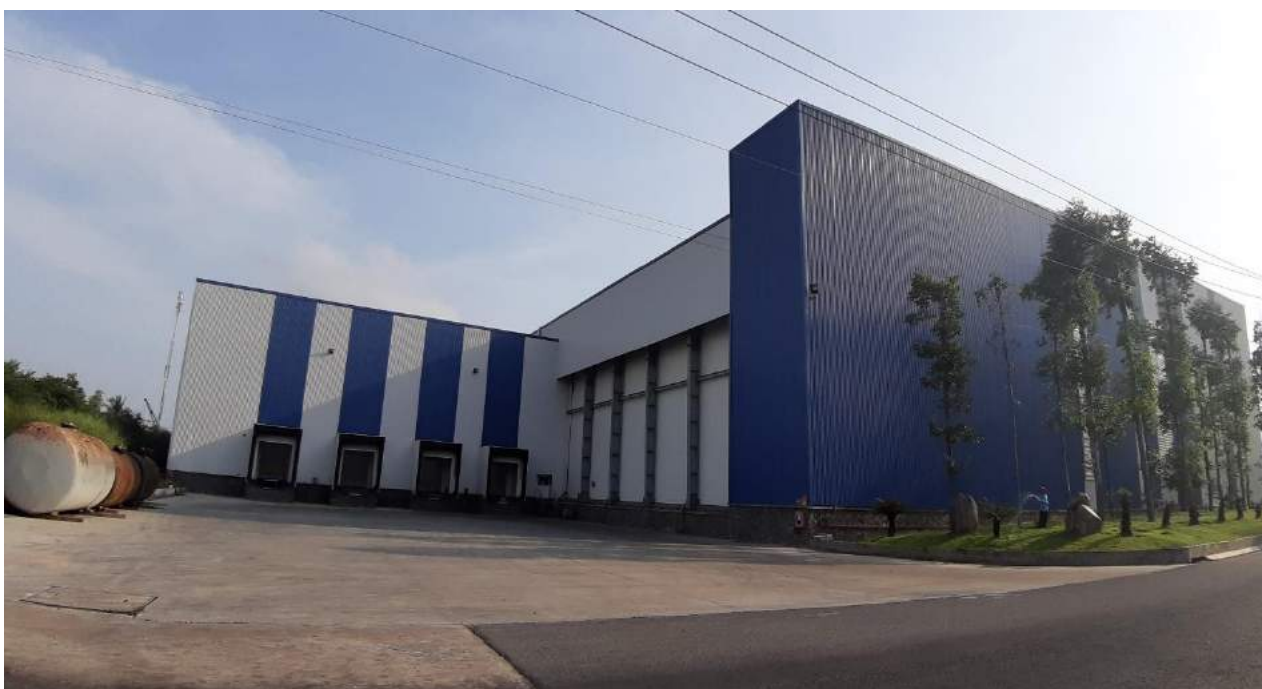
Kho lạnh số 04 với sức chứa 10.000 tấn thành phẩm sẽ hợp thể với Nhà máy số 03
