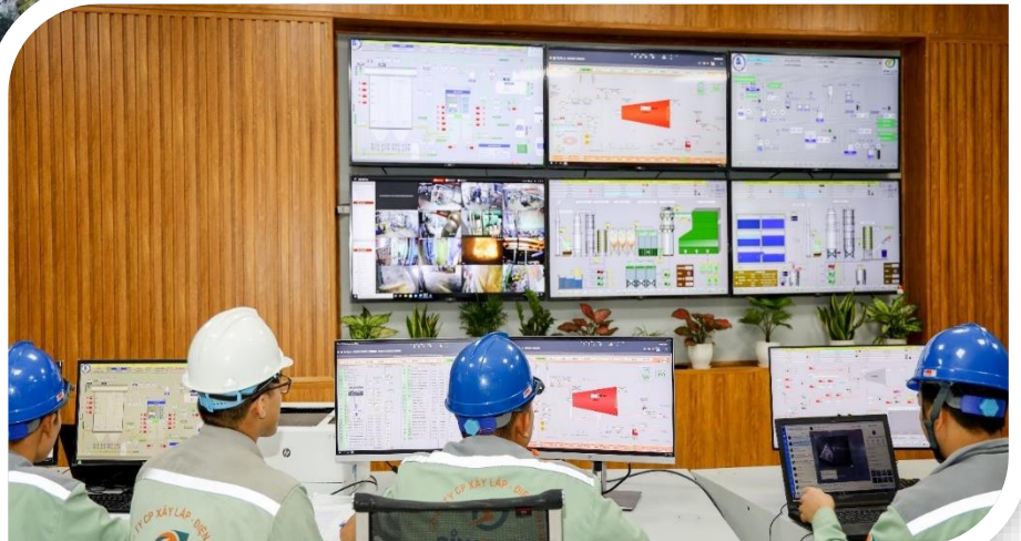
Phòng SCADA điều khiển hệ thống lò đốt rác phát điện
