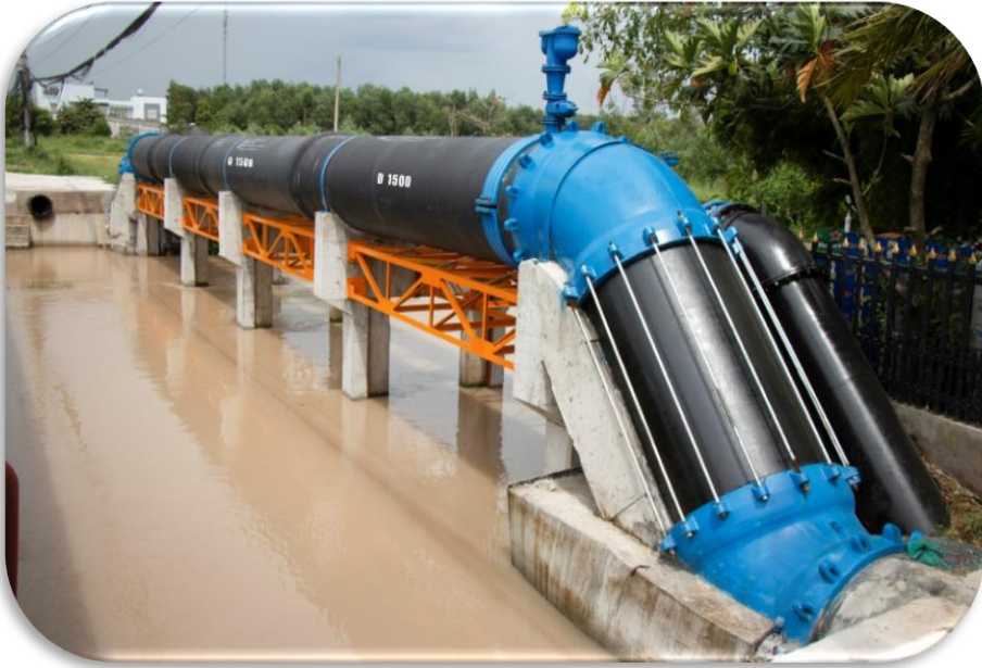
Tuyến ống nước thô Tân Hiệp D1500mm
