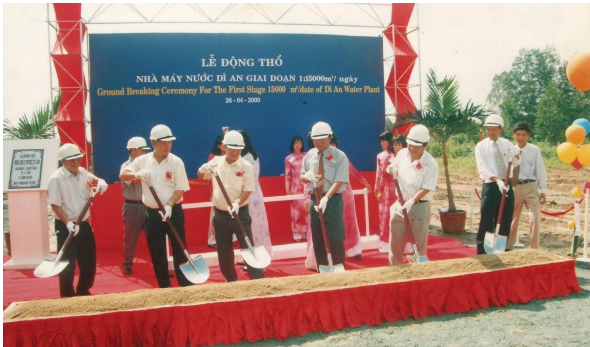
Lễ động thổ Nhà máy nước Dĩ An giai đoạn 1: 15.000m 3 / ngày đêm ngày 26/4/2000 do Chính Phủ Đơn Mạch tài trợ trị giá 3.6 triệu USD. Ông Hồ Minh Phương – Chủ tịch UBND tỉnh Bình Dương tham dự lễ động thổ
