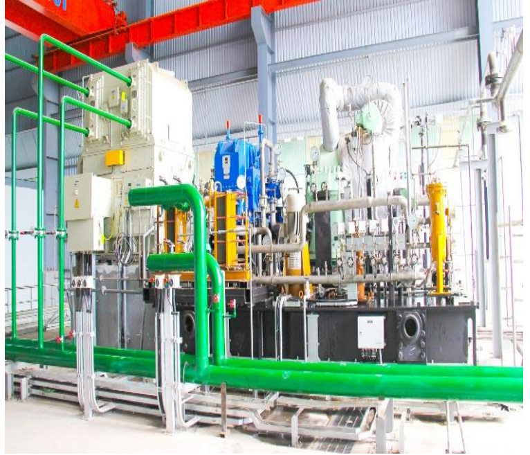
Turbin phát điện 5MW sử dụng nhiệt thu hồi từ lò đốt đã sẵn sàng chờ ngày khánh thành
