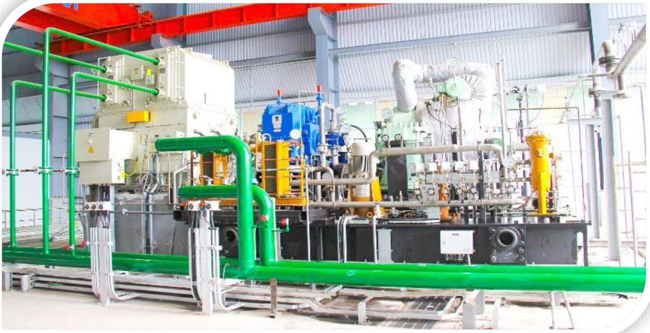
Turbin phát điện 5MW sử dụng nhiệt thu hồi từ lò đốt đã sẵn sàng chờ ngày khánh thành
