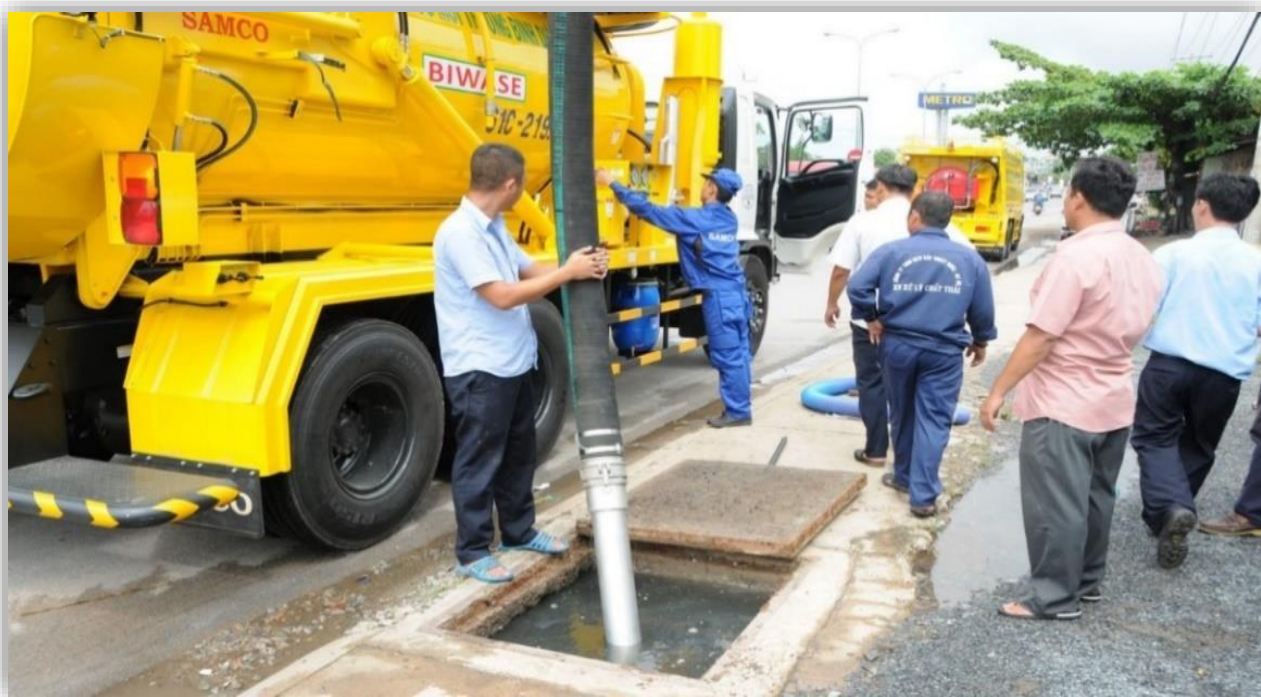
Công việc thi công rửa cống thoát nước và nạo vét hố ga bằng phương tiện, thiết bị cơ giới 100% nên công nhân cũng đỡ vất vả, an toàn
